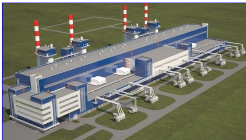
Прегольская ТЭС, 4 ПГУ-110 станция введена в эксплуатацию в декабре 2018г.
