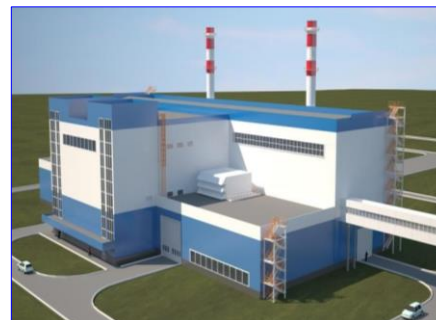
Маяковская ТЭС, ГТУ 2x90 МВт станция введена в эксплуатацию в марте 2018г.
